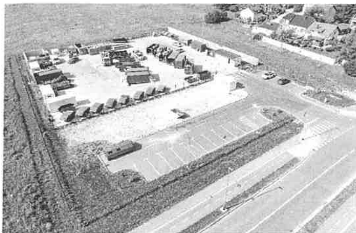
Na slici: Reciklažno dvorište Velika Gorica, Ulica Franje Kirinčića Boška 10, Velika Gorica. Izgradnja i opremanje sufinancirani su sredstvima EU iz Nacionalnog plana oporavka i otpornosti
